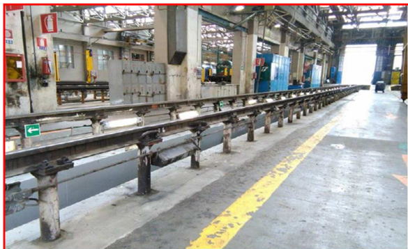
Figura 1 Binari sopraelevati su colonnine
