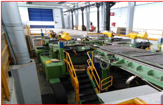
Figura 25 Tornio in fossa
